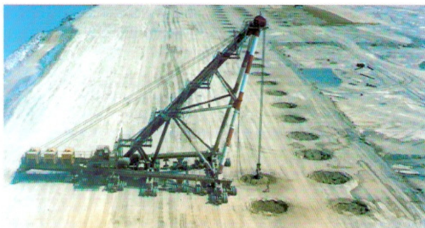
Aeropuerto de Niza - Compactación dinámica pesada Record del mundo - 200 t
