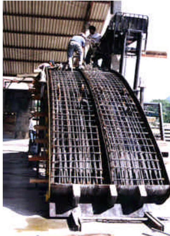
Vaciado de dovelas en taller
